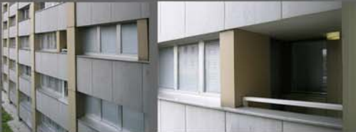
extreme Wärmebrücken
